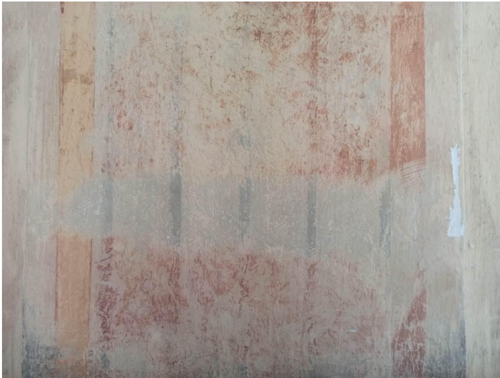
Fot. 16 Lubawka. Kościół p.w. Wniebowzięcia NMP. Sonda usytuowana na ścianie południowej ponad emporą. Odsłonięta warstwa 4/II. Widoczny fragment imitacji kanelowania. Widoczny również bardzo zły stan zachowania obecnie eksponowanej warstwy malarskiej, która jest mocno spudrowana i osypuje się.
