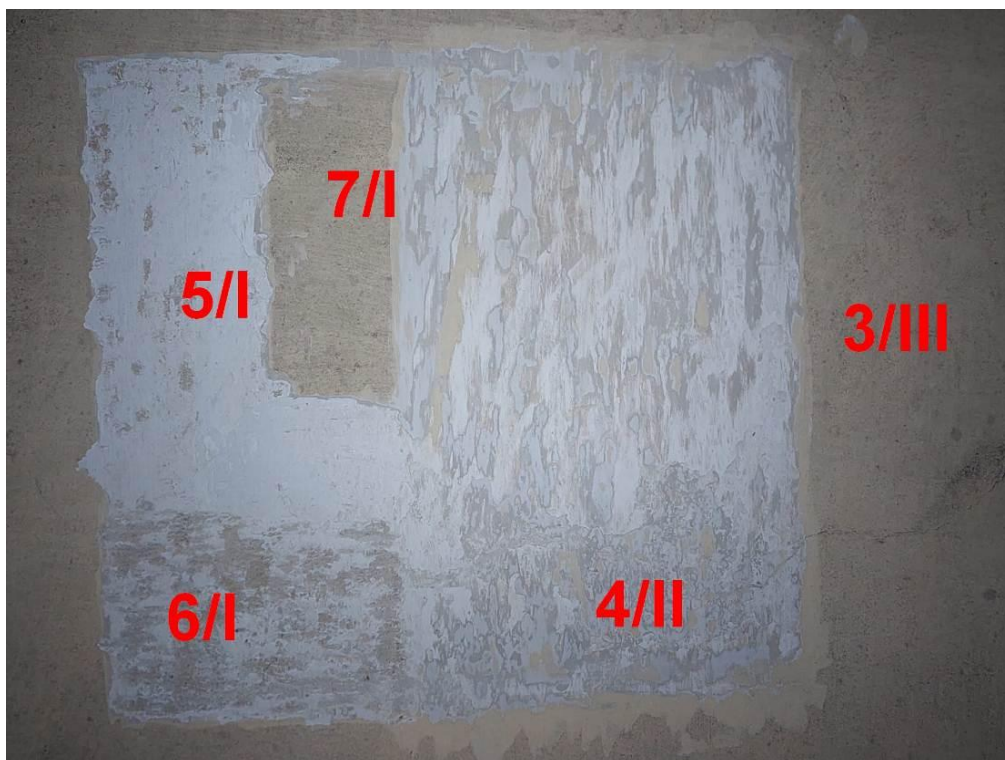
Fot. 2 Lubawka. Kościół p.w. Wniebowzięcia NMP. Sonda usytuowana z prawej strony obrazu wiszącego powyżej północnego wejścia do kościoła. Czerwone oznaczenia odnoszą się do numeracji wynikającej z opracowanej na podstawie badań stratygrafii - patrz tabela 1.
