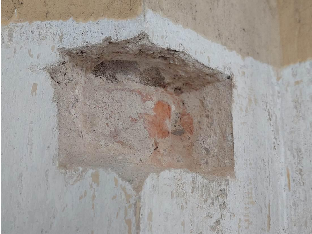
Fot. 13 Lubawka. Kościół p.w. Wniebowzięcia NMP. Fragment sondy schodkowej. Widoczna cegła i kamień, z którego wymurowane są filary międzynawowe.
