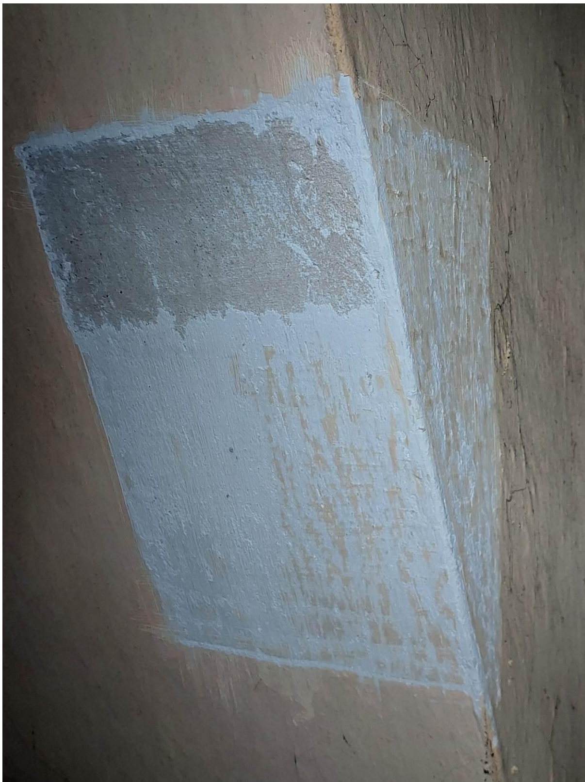
Fot. 4 Lubawka. Kościół p.w. Wniebowzięcia NMP. Sonda usytuowana z lewej strony obrazu wiszącego powyżej północnego wejścia do kościoła, na wsporniku empory. Na sondzie widoczna warstwa tynku (7/I) oraz najstarszych zachowanych pobiał (6/I).
