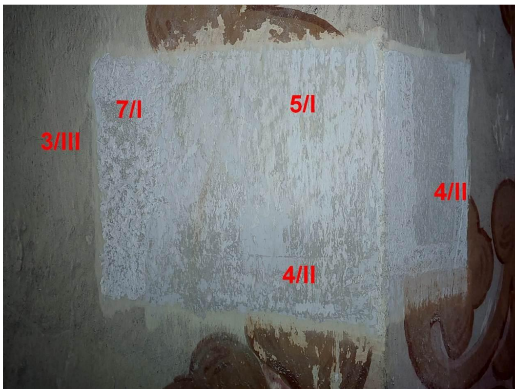
Fot. 9 Lubawka. Kościół p.w. Wniebowzięcia NMP. Sonda usytuowana w glifie okiennym. Czerwone oznaczenia odnoszą się do numeracji wynikającej z opracowanej na podstawie badań stratygrafii - patrz tabela 1.
