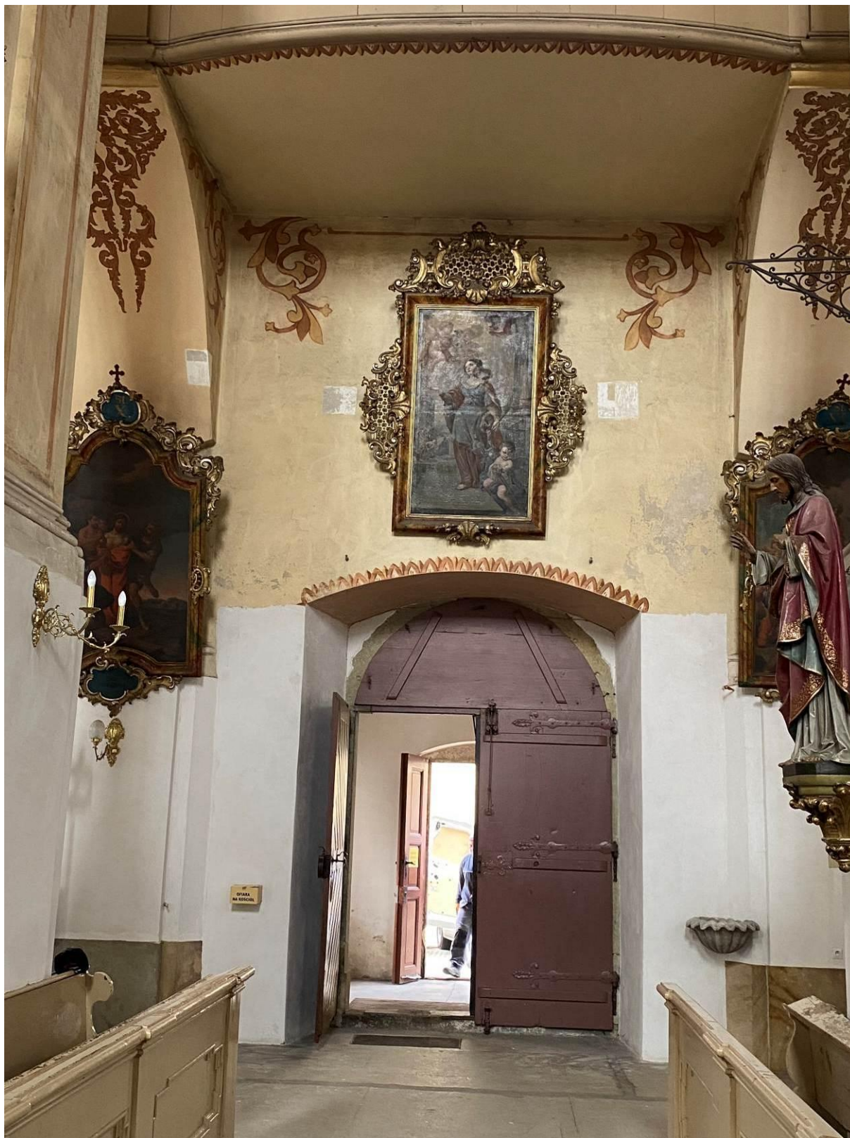
Fot. 1 Lubawka. Kościół p.w. Wniebowzięcia NMP. Fragment wnętrza- widok w stronę północnego wejścia do kościoła. Widoczne usytuowanie trzech sond stratygraficznych.
