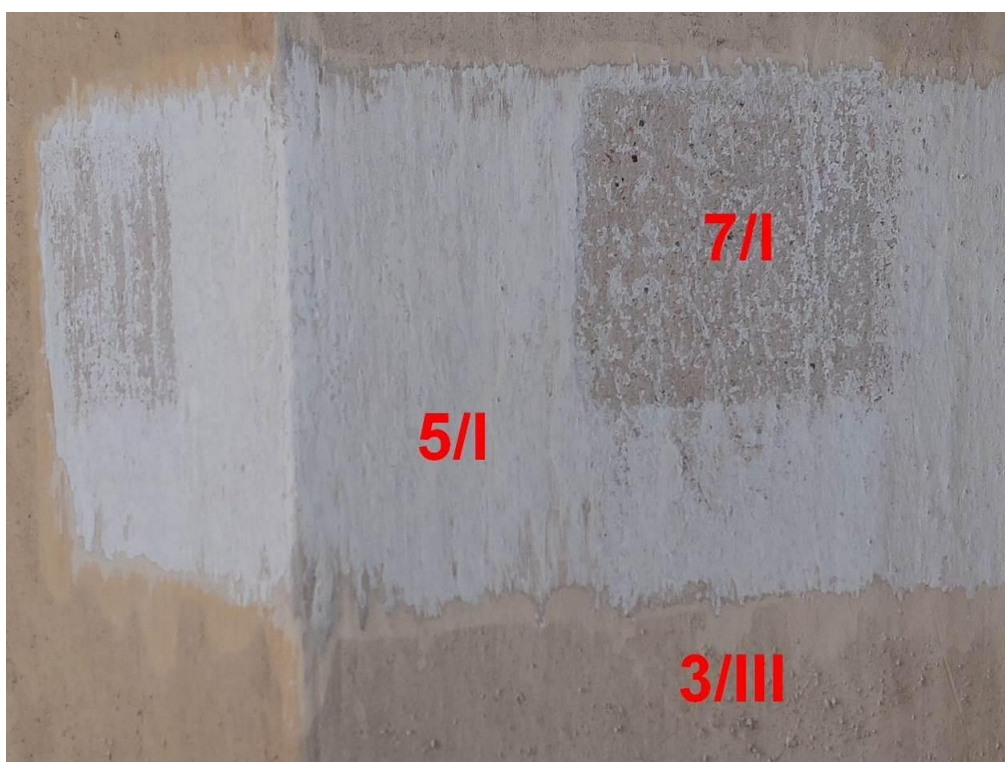
Fot. 7 Lubawka. Kościół p.w. Wniebowzięcia NMP. Sonda usytuowana na zachodniej i północnej ścianie pierwszego północnego filaru międzynawowego. Czerwone oznaczenia odnoszą się do numeracji wynikającej z opracowanej na podstawie badań stratygrafii - patrz tabela 1.
