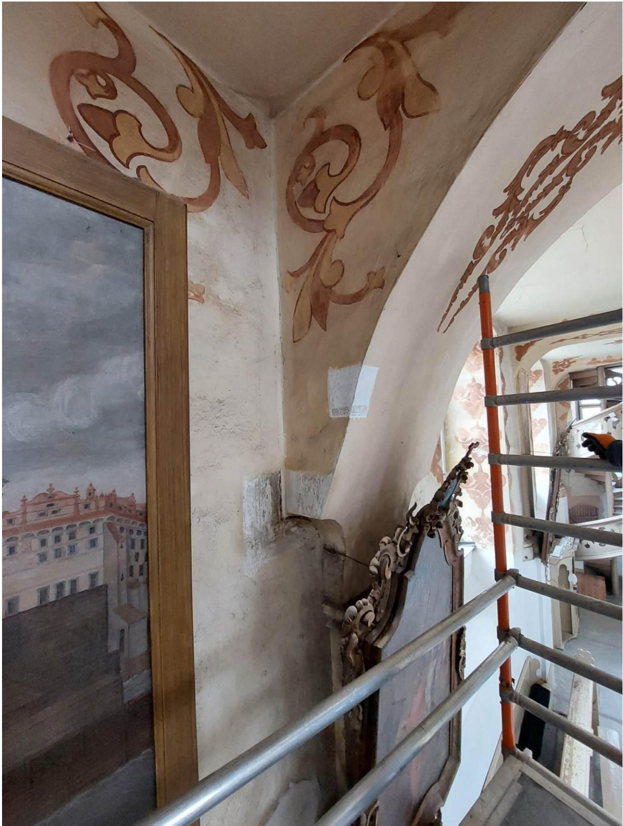
Fot. 10 Lubawka. Kościół p.w. Wniebowzięcia NMP. Fragment wnętrza- widok na trzeci od zachodu wspornik południowej empory kościoła. Widoczne usytuowanie sondy stratygraficznych.
