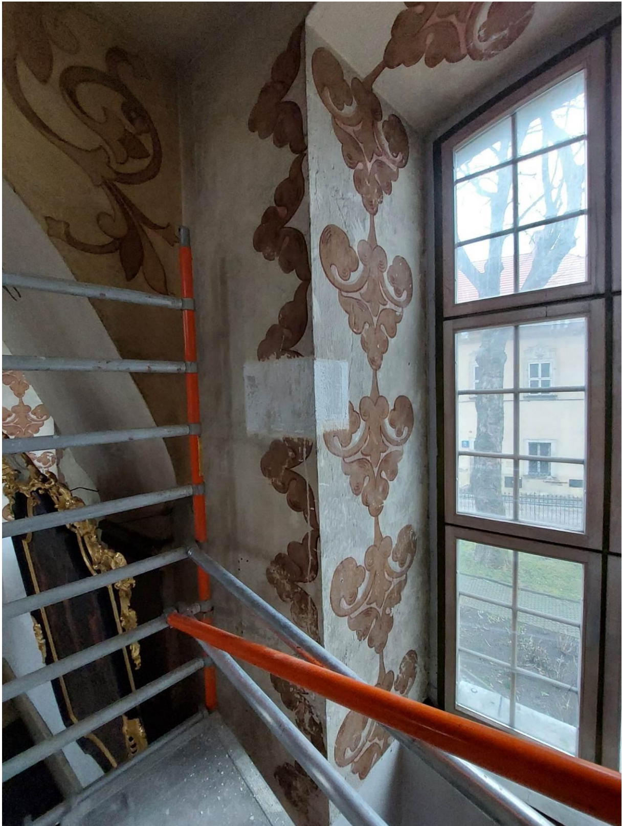
Fot. 8 Lubawka. Kościół p.w. Wniebowzięcia NMP. Fragment wnętrza- widok na glif drugiego okna (licząc od prezbiterium) w północnej ścianie kościoła. Widoczne usytuowanie sondy stratygraficznych.
