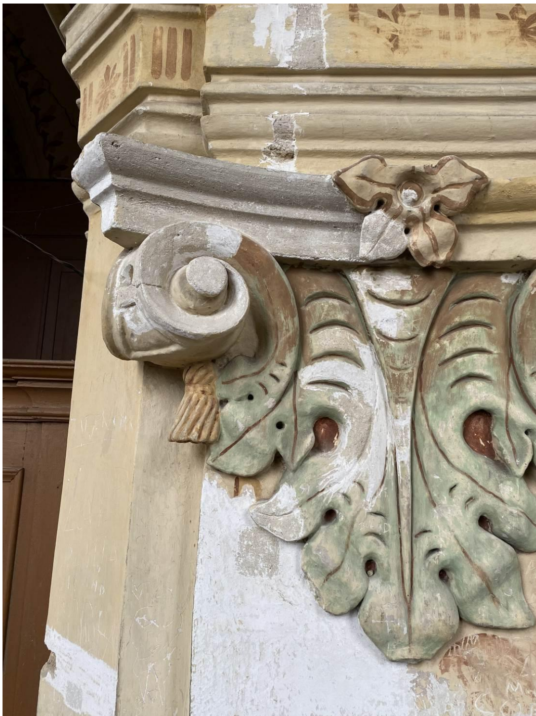
Fot. 18 Lubawka. Kościół p.w. Wniebowzięcia NMP. Sonda usytuowana na jednym z kapiteli pilastrów. Odslonięta pobiała - najstarsza z warstw występujących na wyprawie narzutu. Widoczny brak różnicowania kolorystycznego elementów sztukatorskich.
