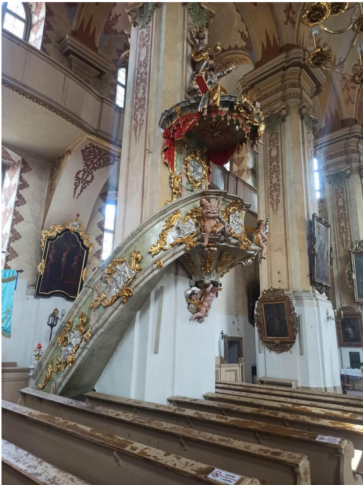
Fot. 28 Lubawka, Kościół p.w. Wniebowzięcia NMP. Fragment wnętrza z amboną i jedną ze stacji drogi krzyżowej po konserwacji. Powierzchnia polichromii mocno zabrudzona a jej charakter nie stanowi dobrego tła dla licznych elementów barokowego wystroju kościoła.
