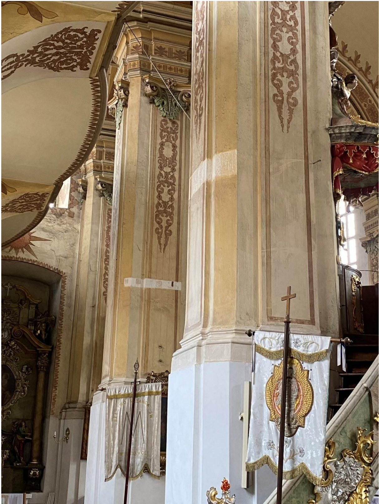
Fot. 5 Lubawka. Kościół p.w. Wniebowzięcia NMP. Fragment wnętrza- widok w stronę wschodnią na północne filary między nawowe (widoczny filar z amboną). Widoczne usytuowanie trzech sond stratygraficznych.
