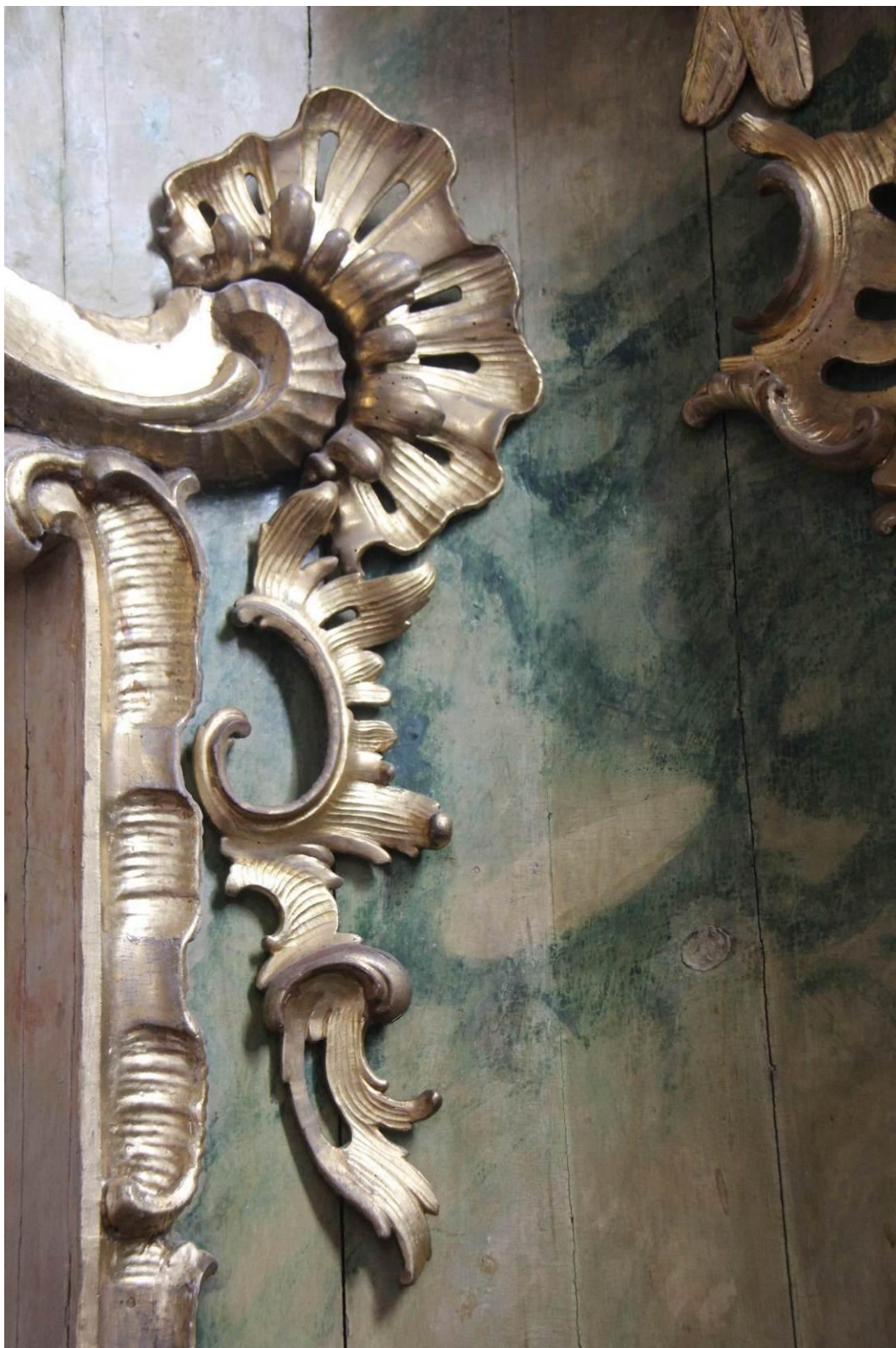
Fot. 21 Lubawka. Kościół p.w. Wniebowzięcia NMP. Fragment marmoryzacji ołtarza głównego.
