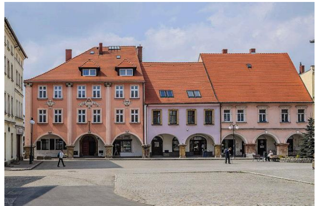
Fotografia 1. Widok na Plac Wolności 6–8, Lubawka - widok od wschodu [3].
