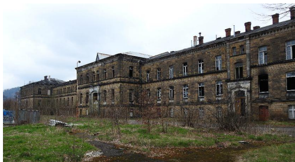
Fotografia 16. Widok na budynek dworca w Lubawce.
