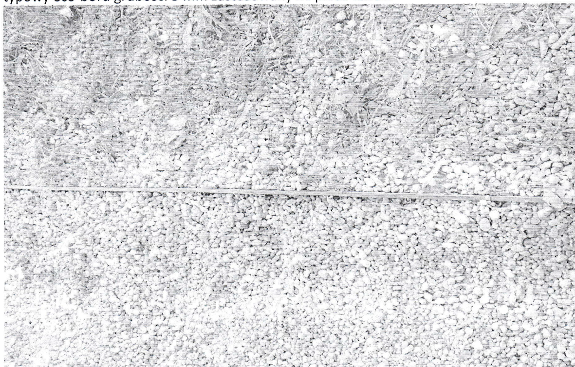
typowy eco-bord grubości 5 mm zastosowany na placu zabaw
