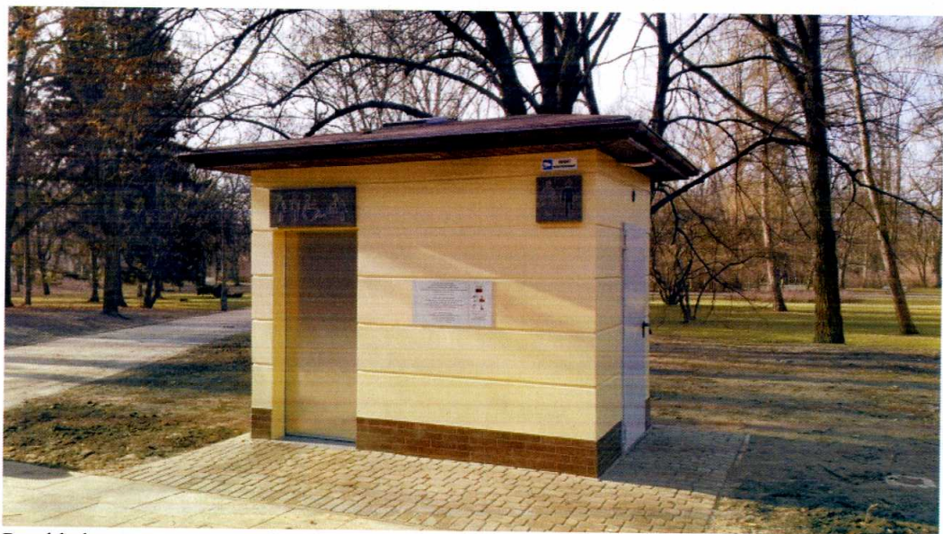
Przykładowa estetyczna toaleta.
