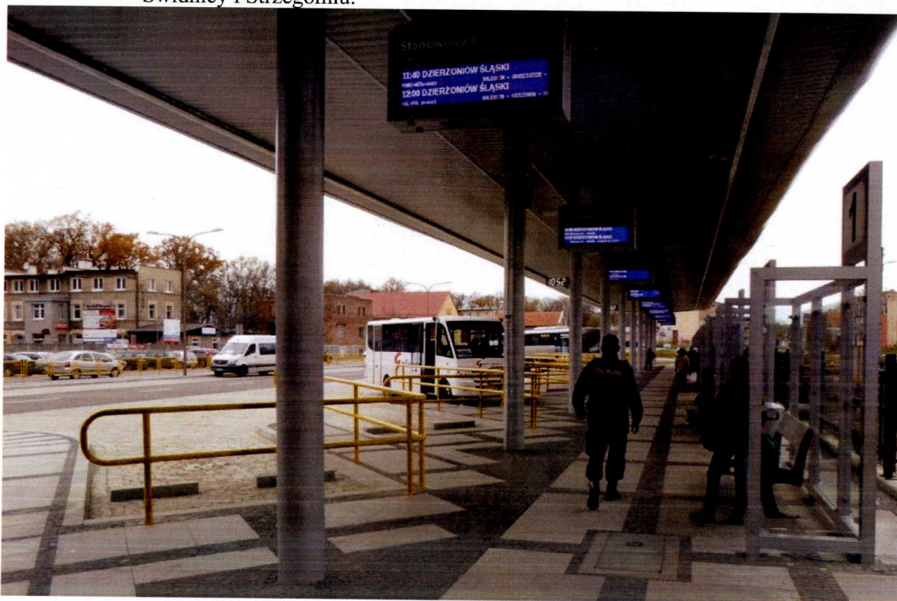
Przykład nawierzchni na dworcu PKS w Świdnicy – kostka granitowa na pl. manewrowym.
