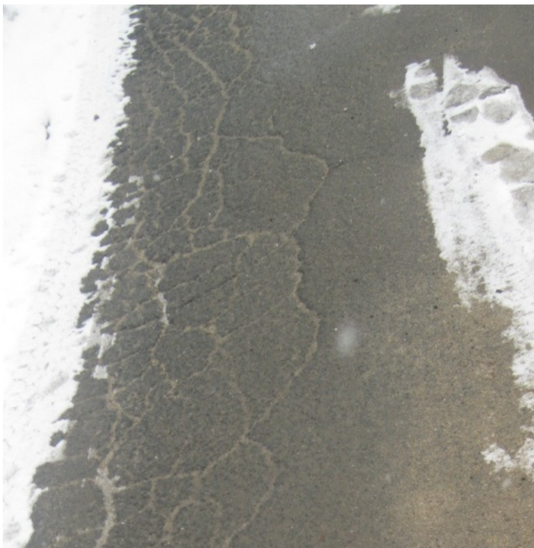
Fot. 2 Spękania nawierzchni
