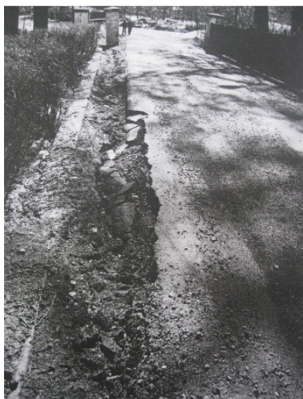
Fot. 2 Degradacja nawierzchni
