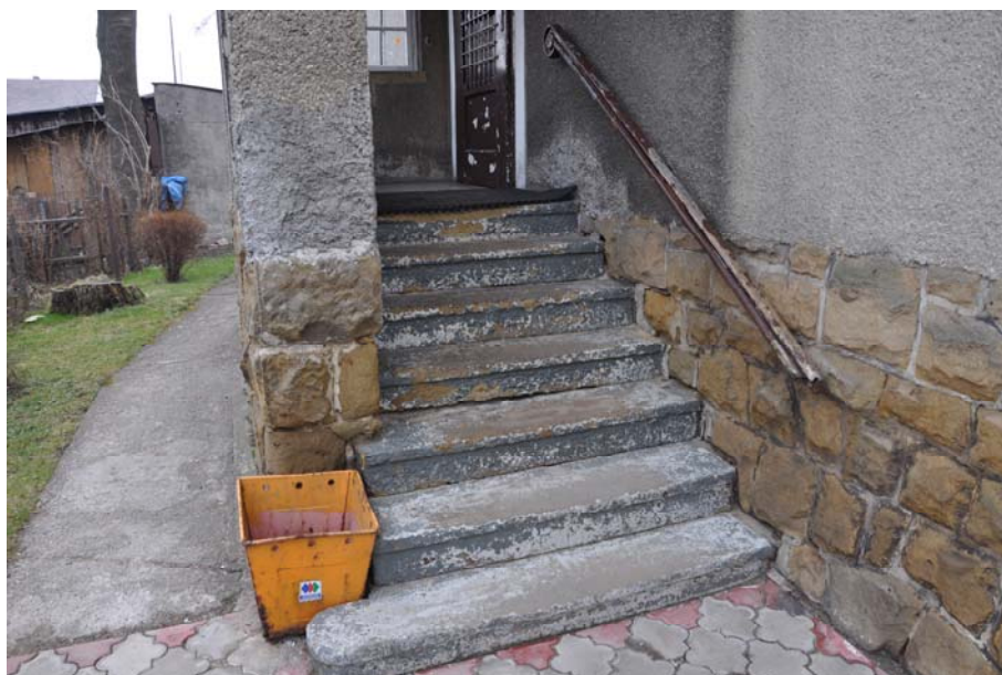
Fot. 8. Widok na kamienne schody wejściowe.
