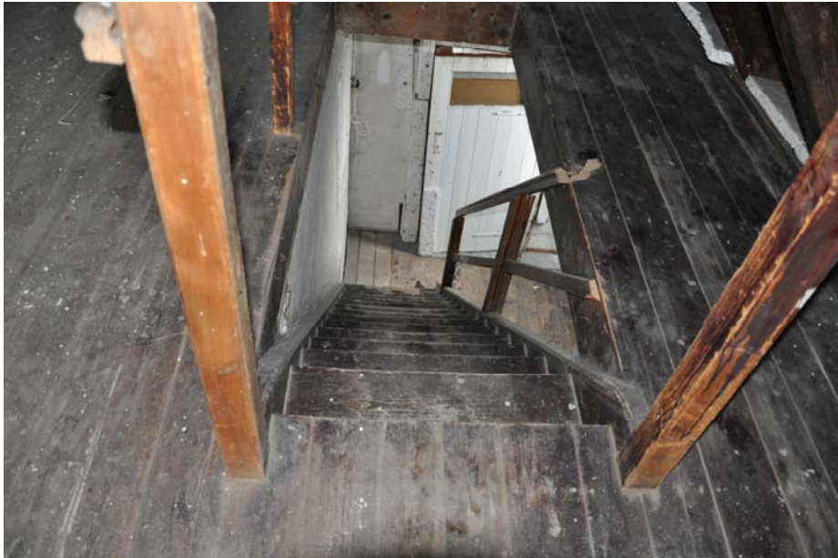
Fot. 29. Widok na schody wejściowe na strych z poziomu poddasza.
