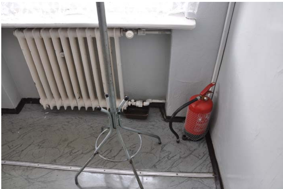
Fot. 31. Widok na typowy grzejnik dla zastosowanego systemu instalacji co. Widoczny przeciek na złączu grzejnika i powrotu.
