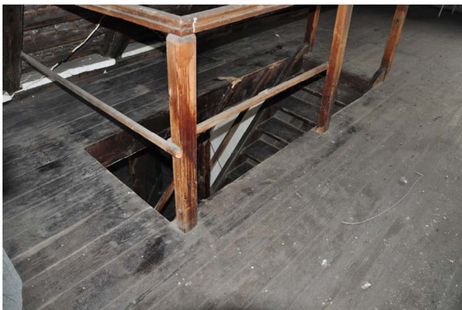
Fot. 28. Strych. Widok na wejście z poziomu poddasza użytkowego.
