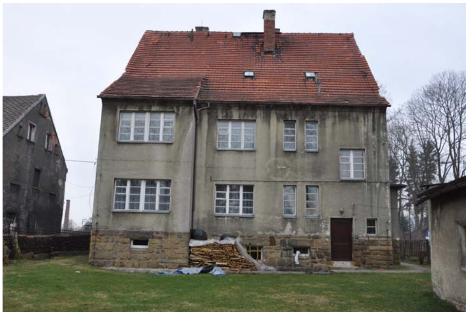
Fot. 3. Elewacja tylna południowo-wschodnia
