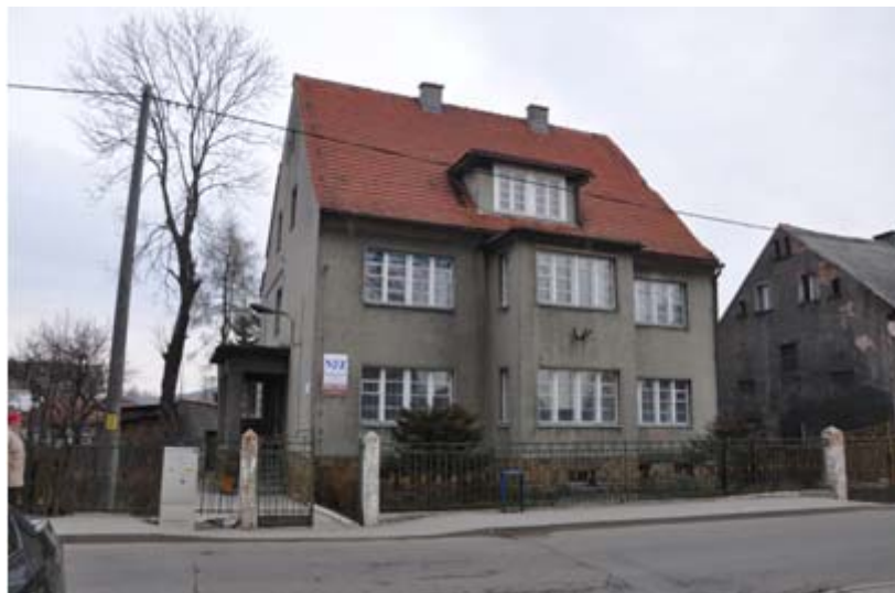
Fot. 1. Elewacja frontowa -południowo zachodnia
