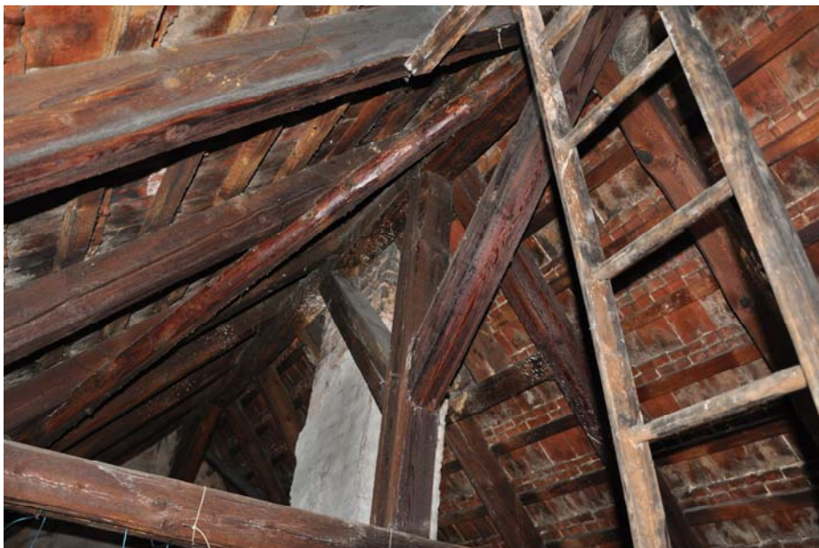
Fot. 27. Strych . Konstrukcja dachu .Widok na konstrukcję słupa wsporczeo płatew Kalenicową.
