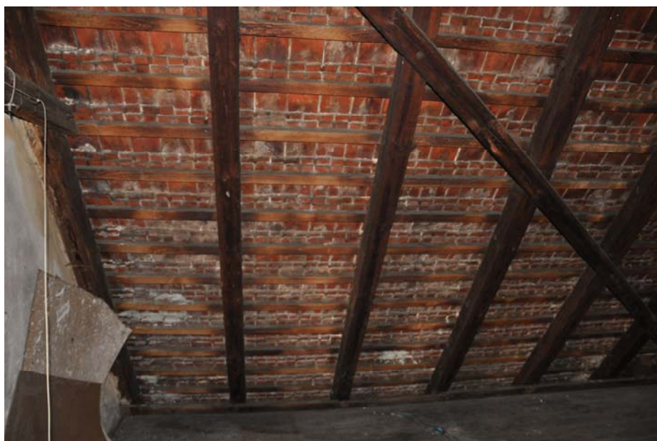
Fot. 26. Część strychowa . Widok na więźbę dachową . Krokwie i zastrzał krokwiowy
