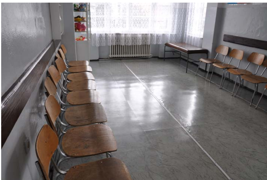
Fot. 19. Parter . Podłoga korytarza pom, nr 6 z ułożoną wykładzina PCV
