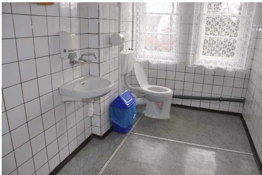
Fot. 23. Piętro I . Pom nr . 22- WC. Widok ogólny.
