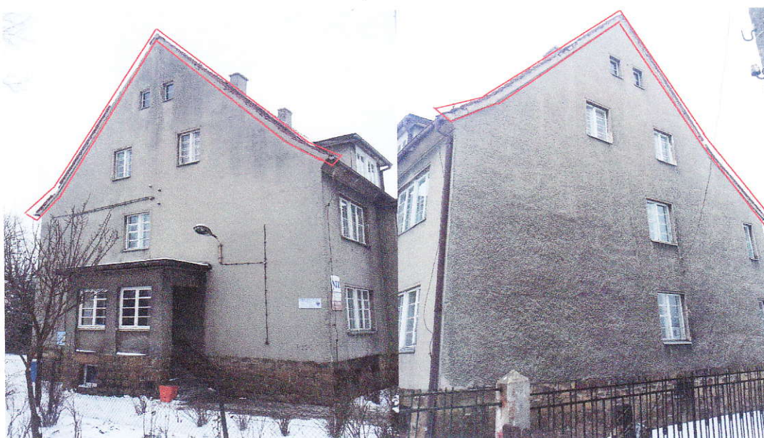
Fot. 1. Elewacje boczne budynku z obszarem zaznaczonym czerwoną linią, który do 10.03.2013 musi zostać zabezpieczony siatką ochronną, aby uniemożliwić na czas remontu zasiedlenie budynku przez ptaki.
