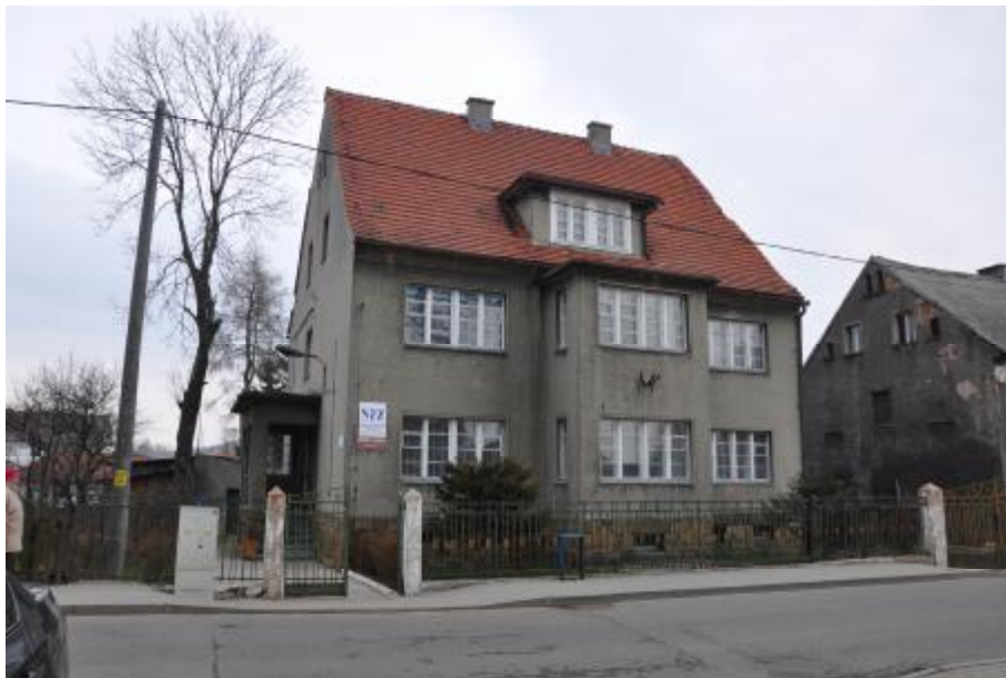
Fot. 1. Elewacja frontowa -południowo zachodnia
