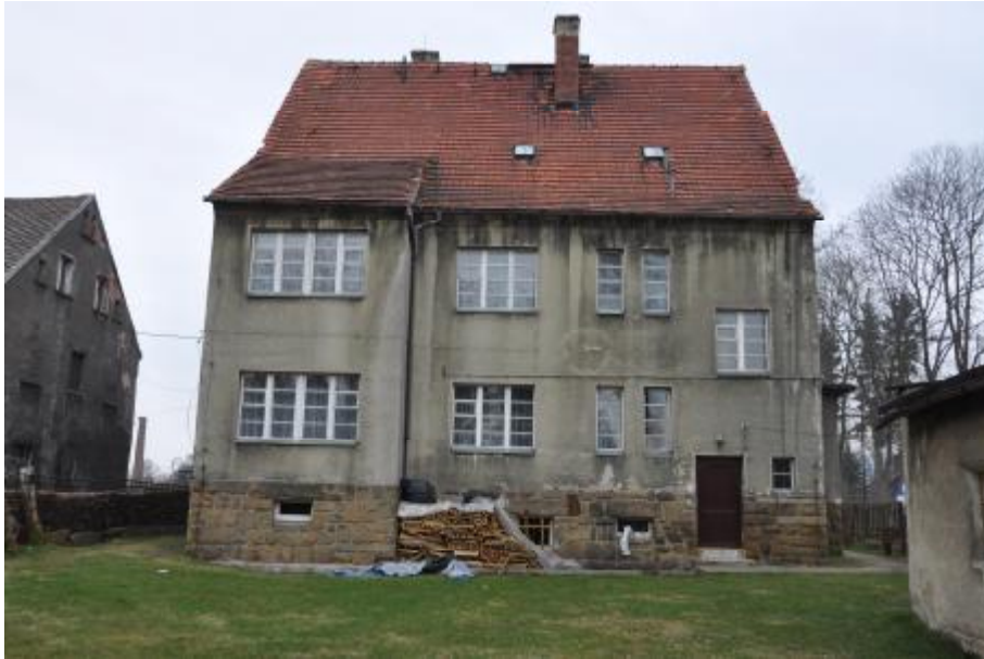
Fot. 3. Elewacja tylna południowo-wschodnia
