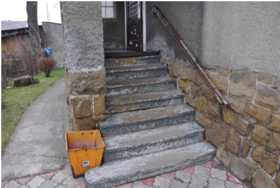
Fot. 8. Widok na kamienne schody wejściowe.
