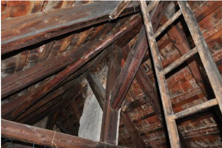
Fot. 27. Strych . Konstrukcja dachu .Widok na konstrukcję słupa wsporczego płatew Kalenicową.
