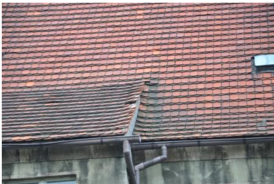
Fot. 34. Kolejny widok pokrycia dachowego od strony ogrodu.
