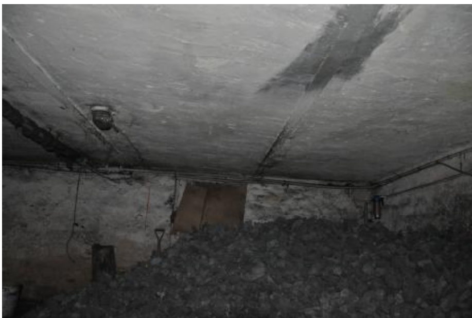
Fot. 12. Piwnica skład opału pom. nr 06. Widok na strop ceramiczny na legarach stalowych
