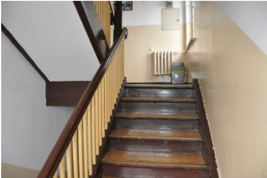
Fot. 18. Klatka schodowa . Widok na schody drewniane . Wejście na poziom piętra
