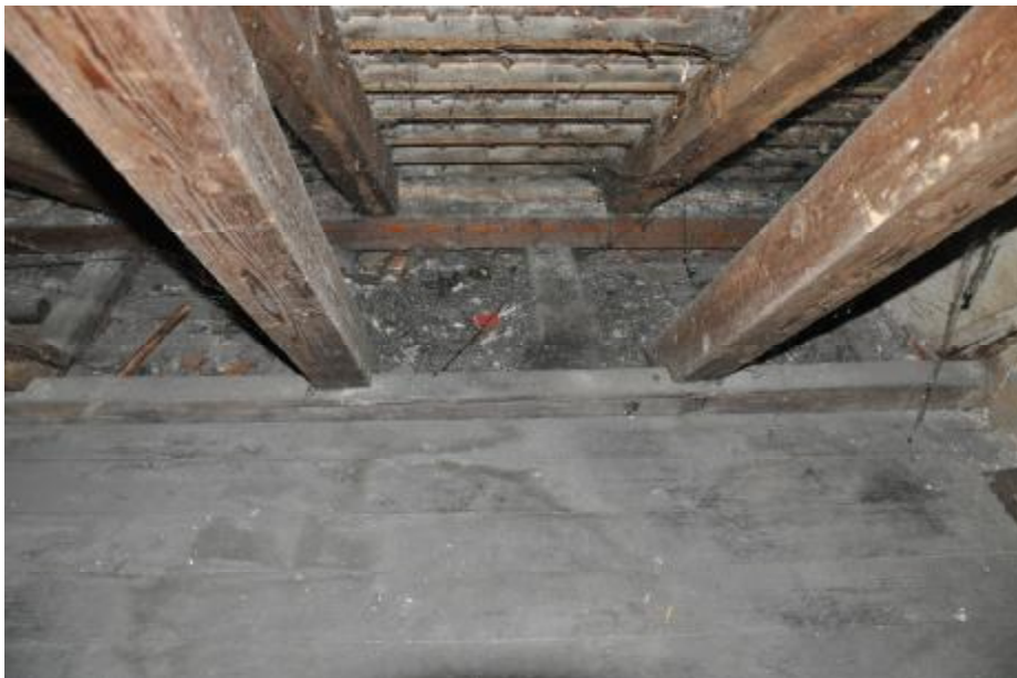
Fot.25. Poddasze użytkowe . Pomieszczenie gospodarcze . Widok na część przypodłogową i konstrukcję dachu.
