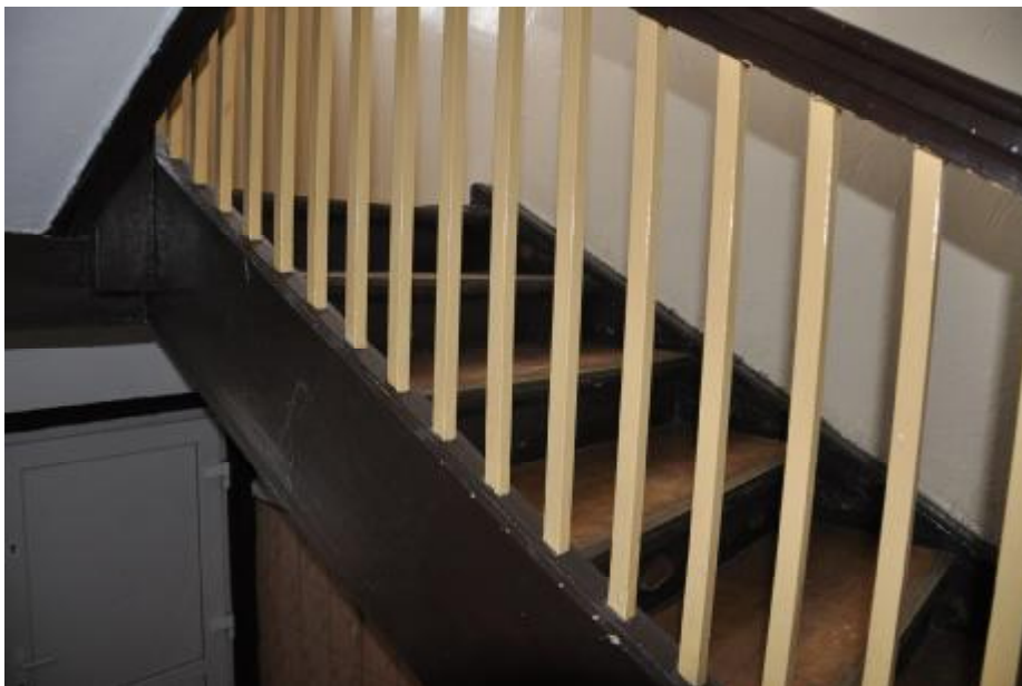
Fot. 10. Widok na schody drewniane klatki schodowej Poziom parteru.
