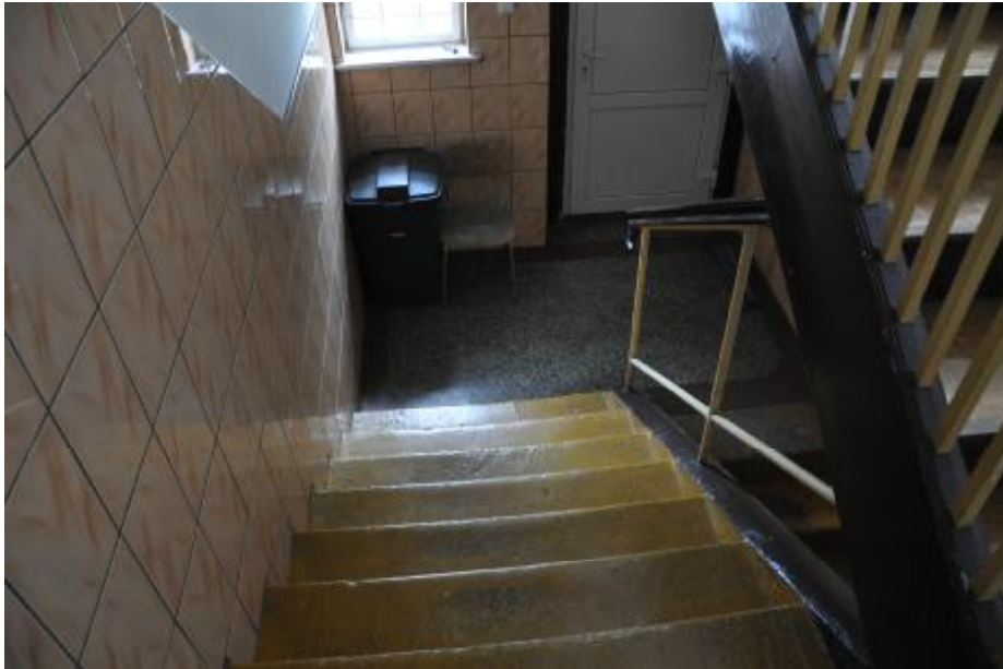
Fot. 9. Widok na schody betonowe do piwnicy.
