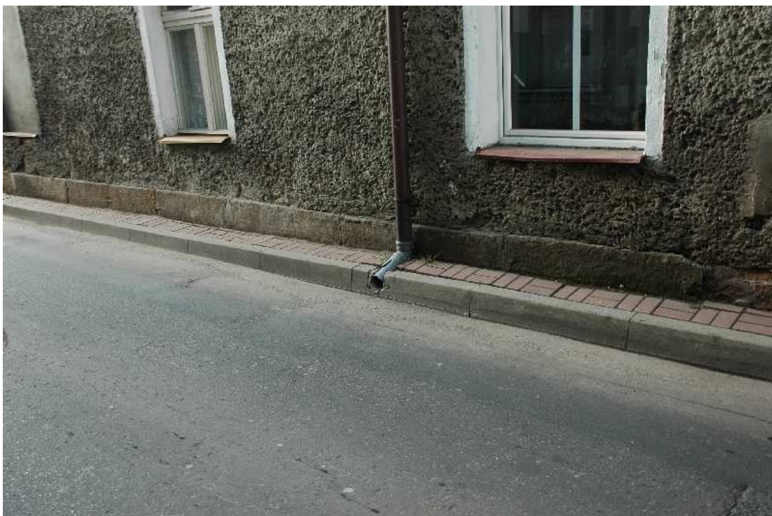
fot. 19 – Sposób odprowadzenia wody z rynien
