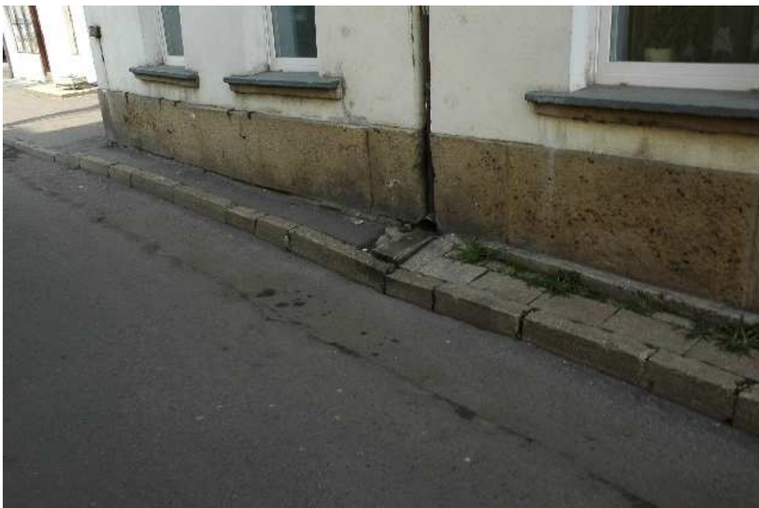
fot. 8 - przykład rynny wypuszczonej na jezdnię
