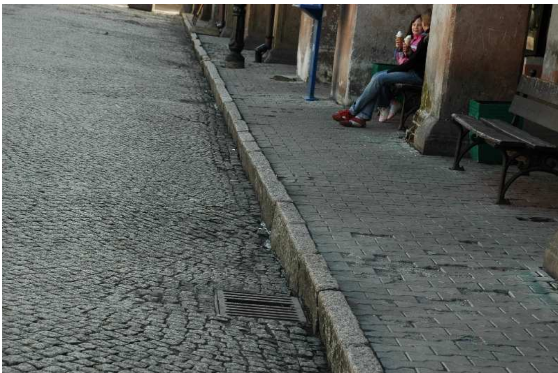
fot. 15 – Połączenie krawężnika i chodnika
