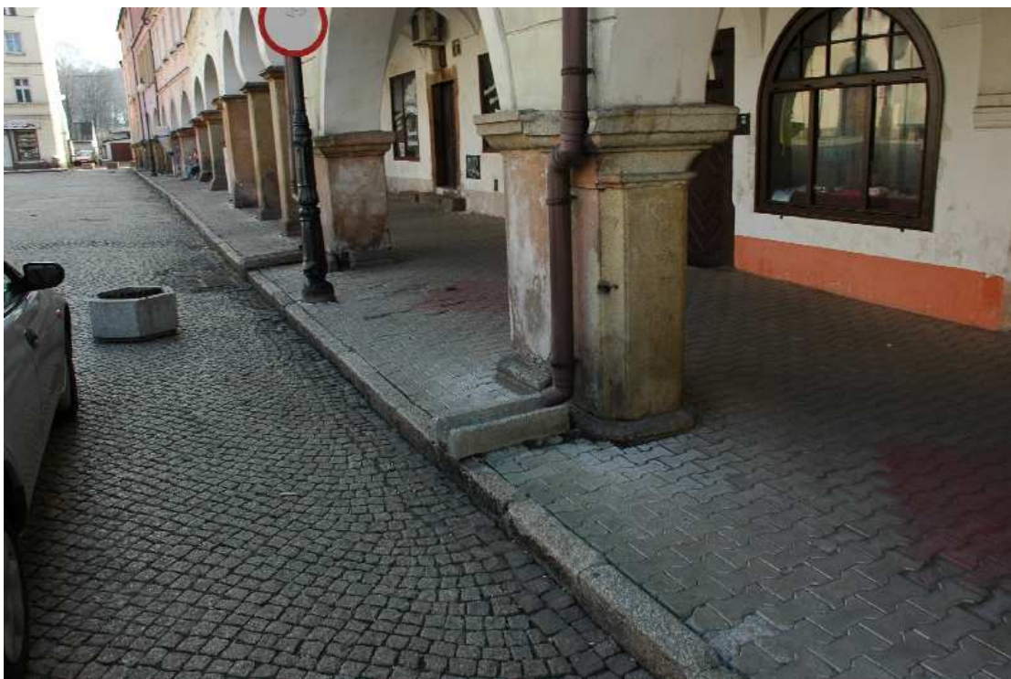
fot. 14 – Istniejący sposób odprowadzenia wody z rynien
