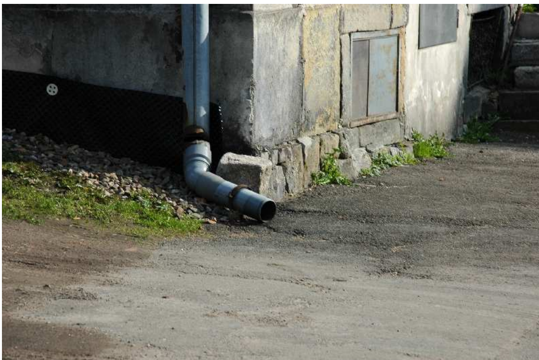
fot 7 – przykład rynny wypuszczonej na chodnik
