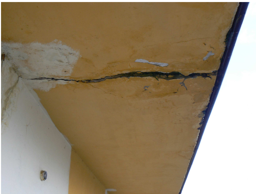
Fot. NR 4 . USZKODZENIE PŁYTY DASZKU (PRZY GŁÓWNYM WEJŚCIU)
