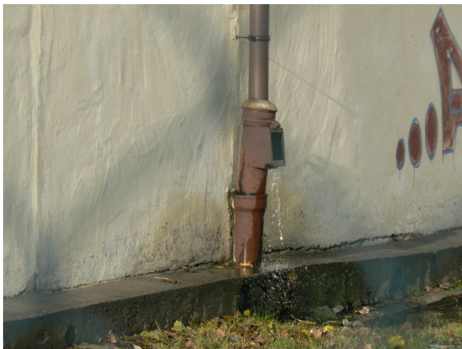
Fot. NR 2 . ZATKANY PION SPUSTOWY DO KANALIZACJI DESZCZOWEJ
