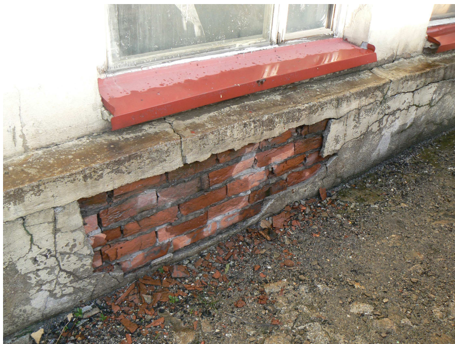
Fot. NR 1 . ZLASOWANA I ZAWILGOCONA CEGŁA ŚCIAN PRZYZIEMIA
