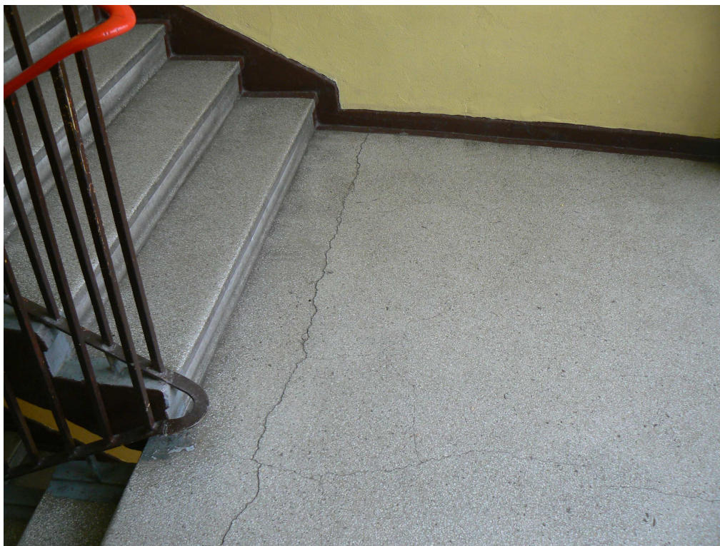
Fot. Nr 6 . PĘKNIĘCIE SPOCZNIKA NA ŁĄCZENIU Z PODCIĄGIEM
