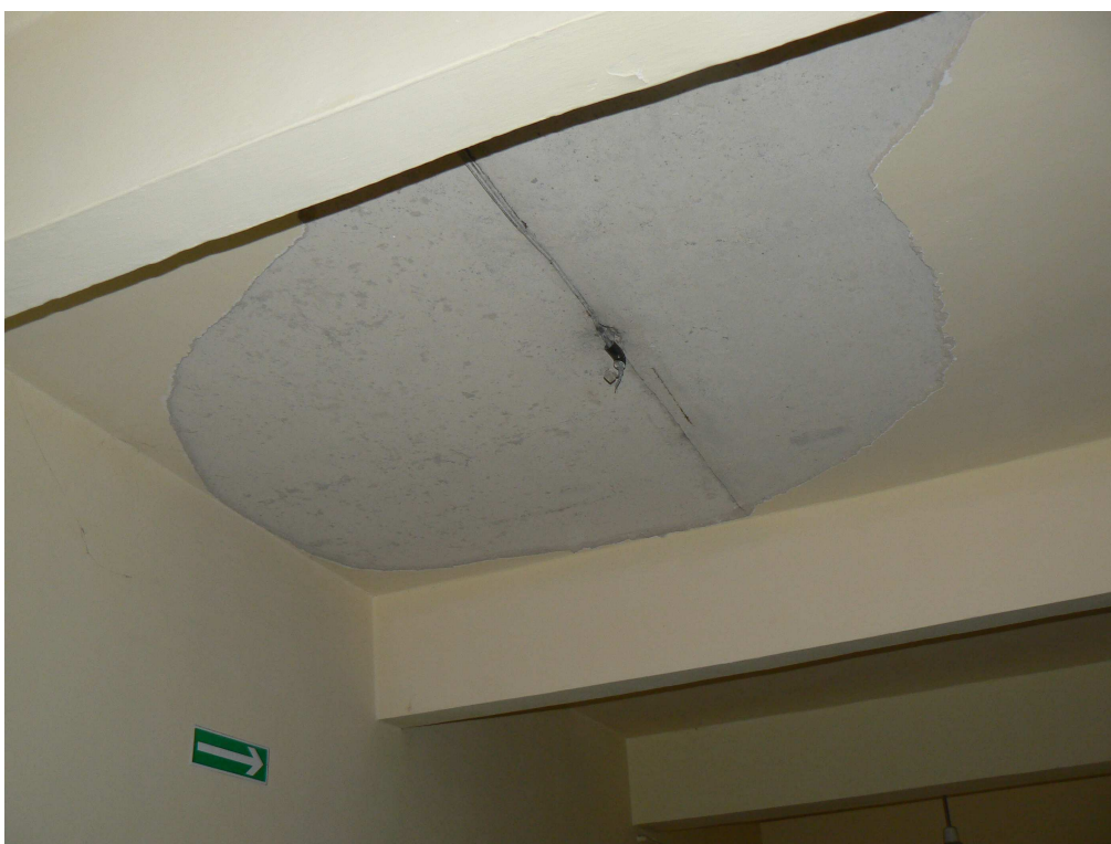
Fot. Nr 5 . ODSPOJONY TYNK SUFITU NA KORYTARZU
