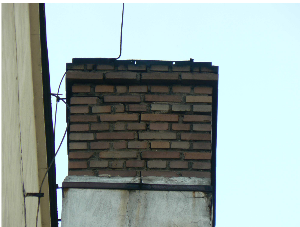
Fot. NR 3 . ROZSZCZELNIENIE KONSTRUKCJI KOMINA
