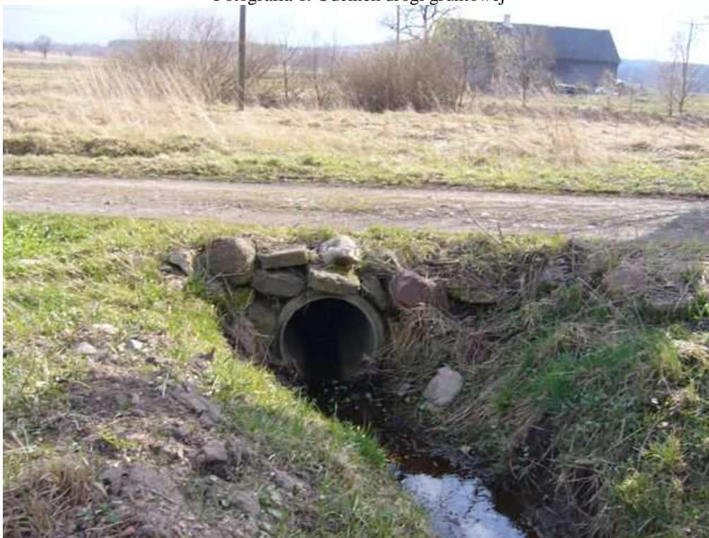
Fotografia 2. Przepust do przebudowy w celu zwiększenia światła
